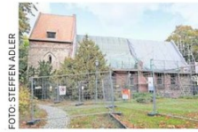
Kirche wird saniert Zimmerleute arbeiten in Koserow in luftiger Höhe. Seite 12
